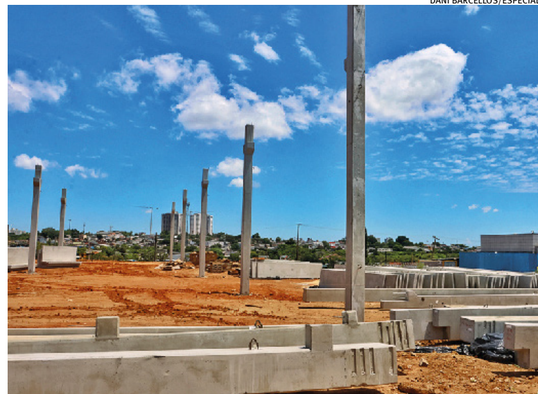
Obra da nova unidade está em construção na zona Norte da Capital
