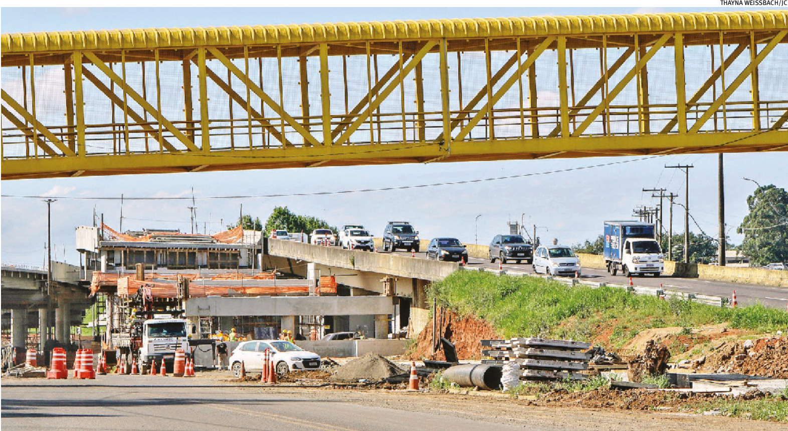
Intervenções na rodovia ganharam reforço e vão melhorar o fluxo em frente ao Parque de Exposições Assis Brasil, onde acontece a Expointer p. 20
