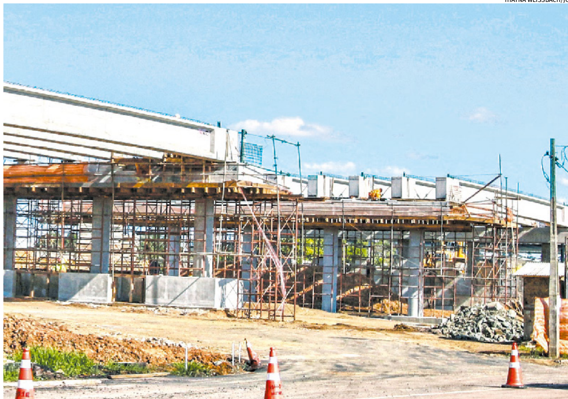
Trecho da BR-116 em Esteio concentra obras de execução de três viadutos e duas pontes sobre o Rio Sapucaia
