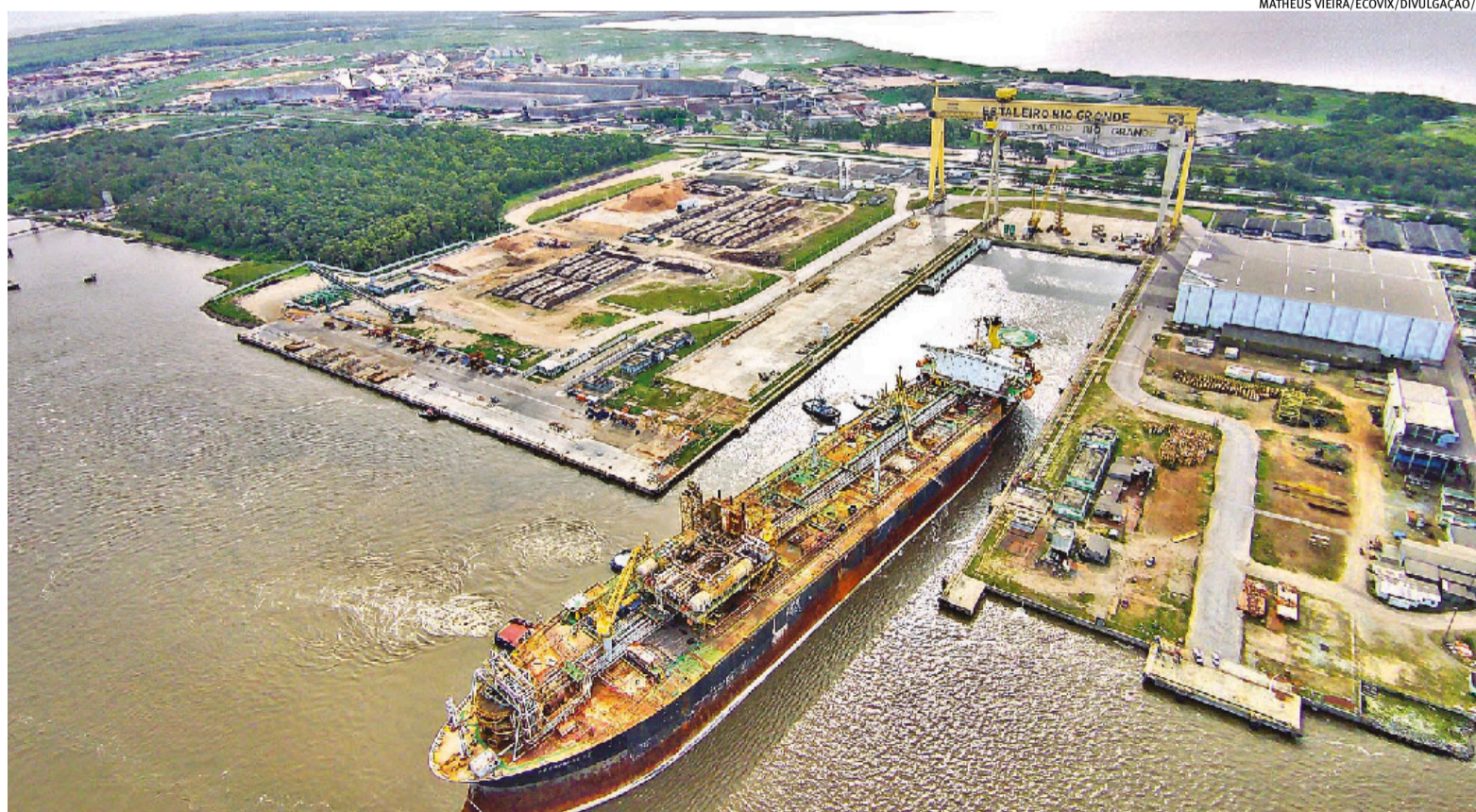
Plataforma P-32 chegou ao Estaleiro Rio Grande no final de 2023; constatação de grande volume de óleo impede o desmanche da estrutura
