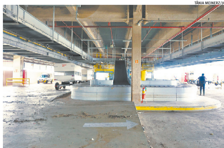
Na área de transporte de bagagens, parte do piso sofreu elevação
