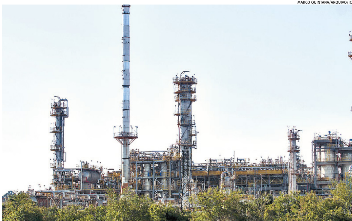
Refap, localizada na cidade de Canoas, é um dos principais complexos da estatal no Rio Grande do Sul
