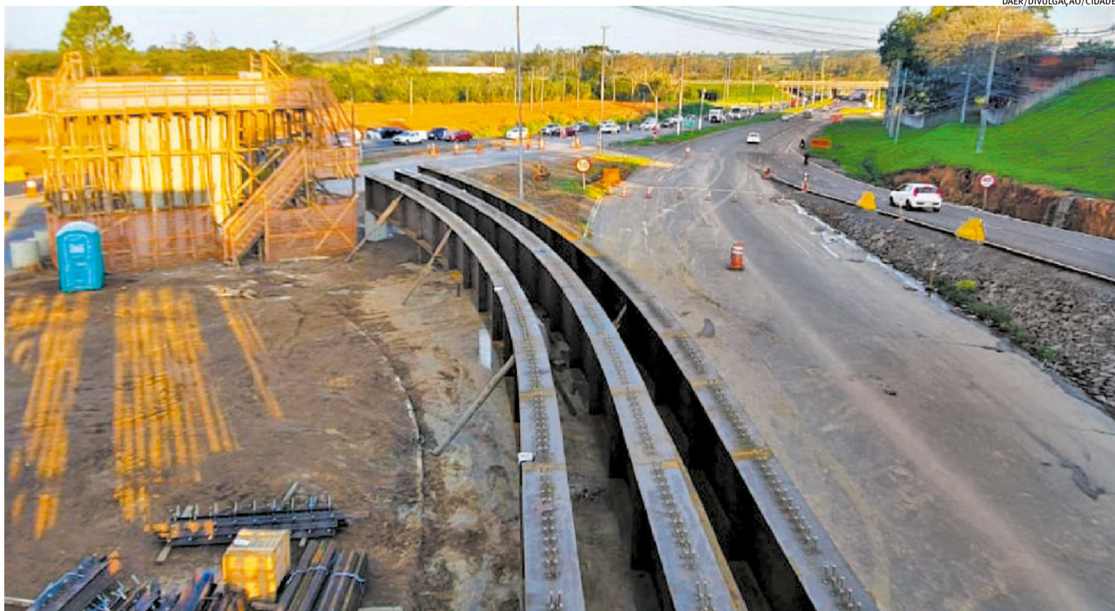
Entre as 65 obras de ligações regionais e acessos municipais, destaque para a interseção da ERS-118 com a ERS-030, com R$ 13 milhões investidos ao longo deste ano
