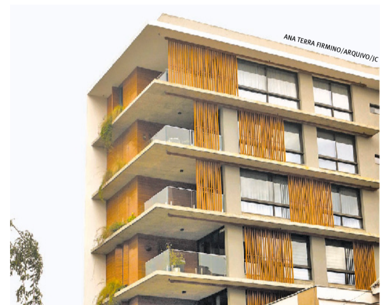
Edifício é reconhecido, inclusive, por departamentos internacionais
