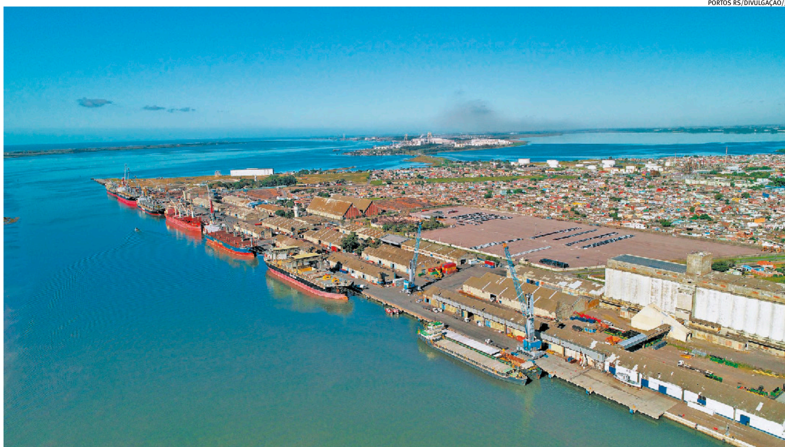
Obra de manutenção, a ser feita anualmente no complexo, dará mais segurança à operação de navios, com calado de 15 metros no canal interno
