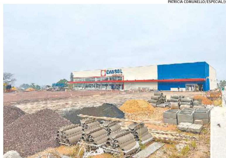
Viamão: filial é ao lado da Havan e está nos acabamentos da obra
