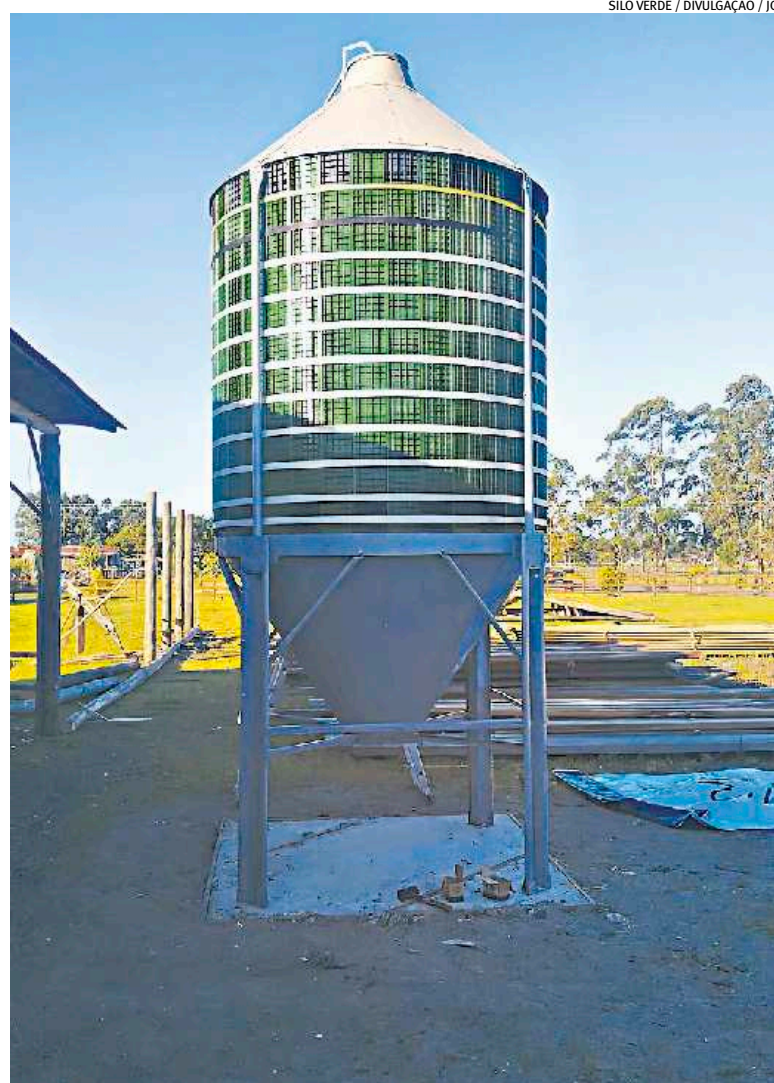
Cada estrutura utiliza 4 mil garrafas PET em sua composição
