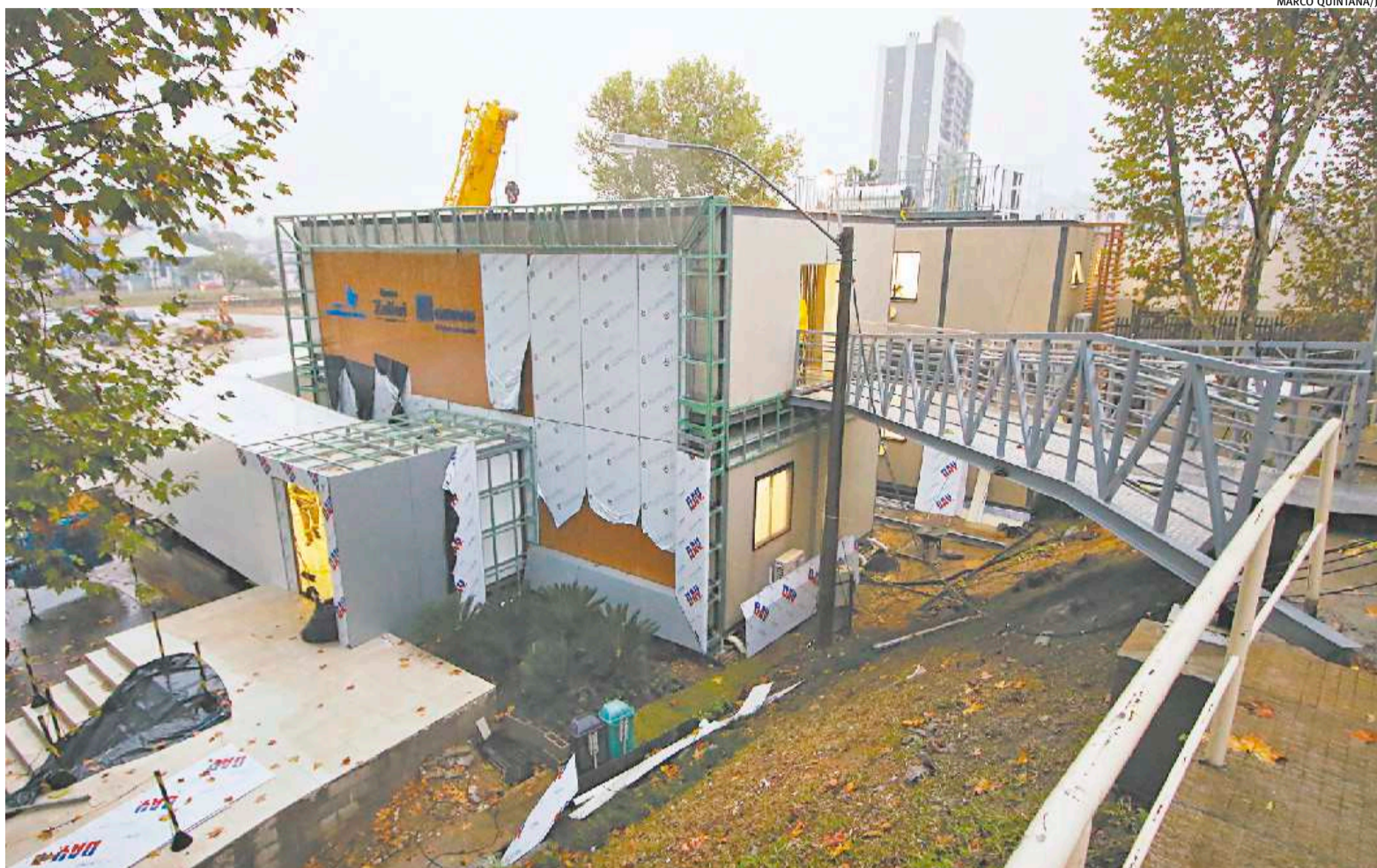
Hospital que Gerdau, Ipiranga e Zaffari estão erguendo na Capital ficará pronto no próximo dia 30 de maio; Hospital Moinhos de Vento é parceiro
