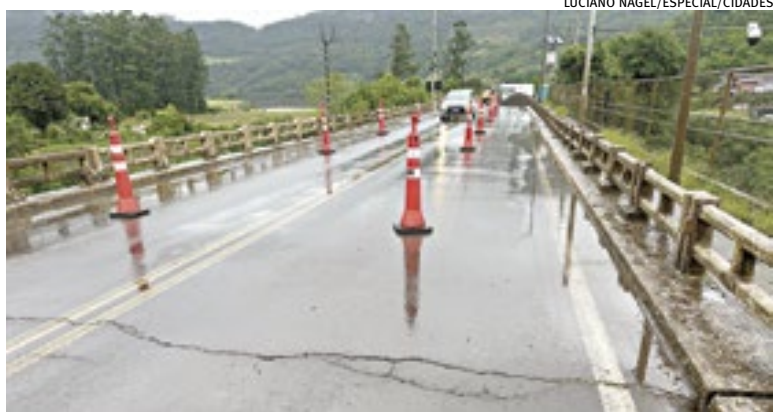
Ponte entre Muçum e Encantado, na ERS-129, está bloqueada desde o mês de julho
