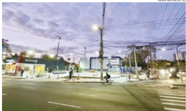
Instalações estão quase prontas na região do campus da Pucrs
