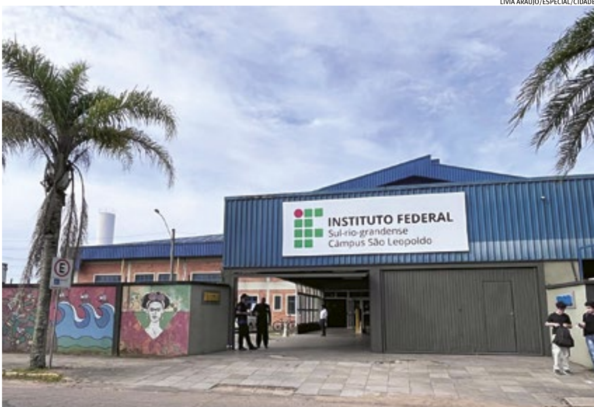
Instalado no antigo Centro de Eventos, a sede tem 7.7 mil metros quadrados de área construída no bairro Fazenda São Borja
