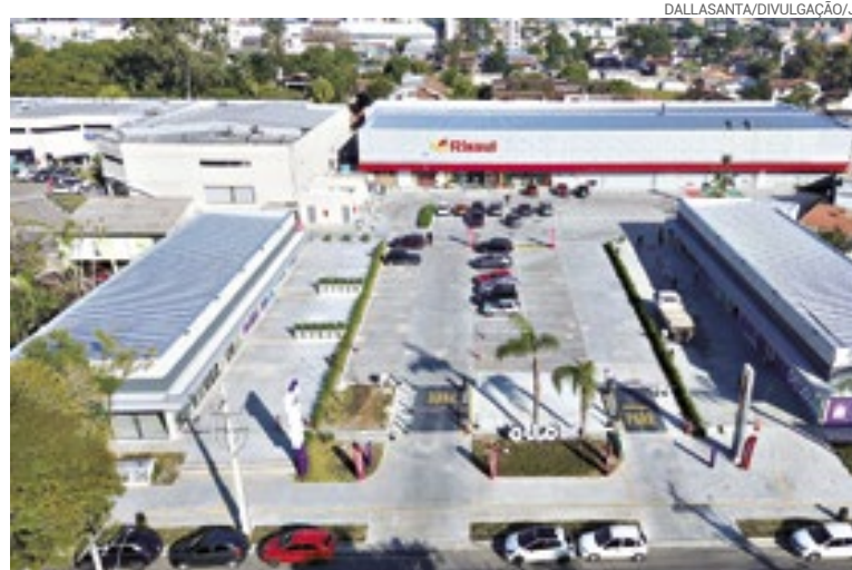
A unidade da Zona Sul ficará no complexo Otto 2500
