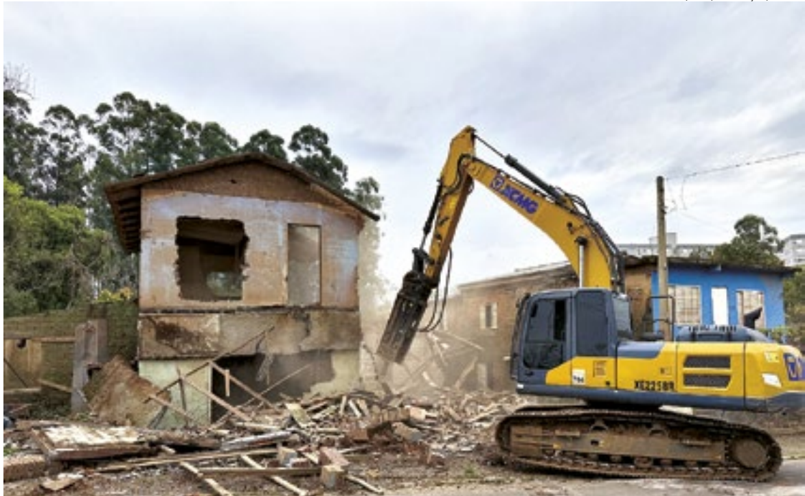
Cerca de 40 imóveis já foram demolidos desde o início do plano de desocupação, que engloba famílias entre cotas 19 e 24
