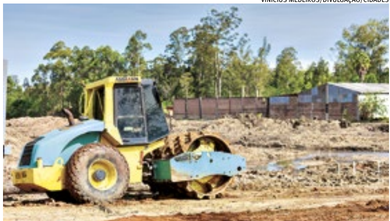
Com investimento de R$ 161 milhões, prazo de construção previsto é de 18 meses
