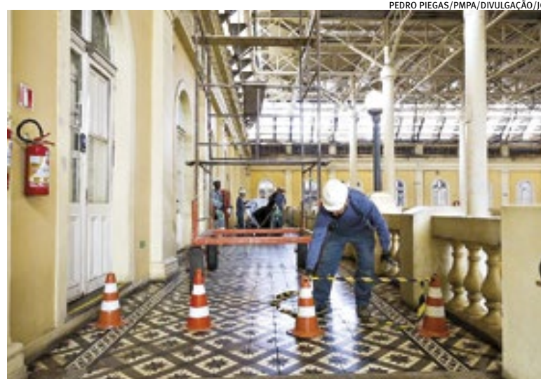
Com investimento de R$ 944 mil, o prédio terá novas calhas e pintura
