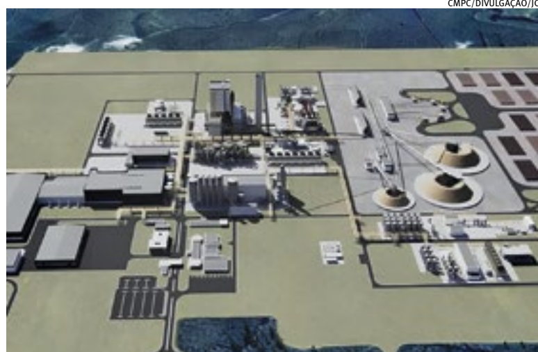
Após análise técnica concluída, fundação pede manifestações técnicas
