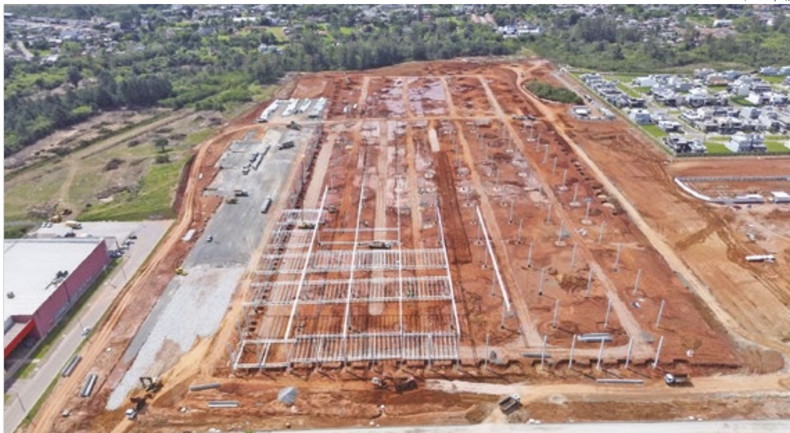
Gigante do e-commerce constrói segundo complexo no RS, em área da Dallasanta; aporte é de R$ 300 milhões e prevê 2 mil empregos Caderno JC Logística
