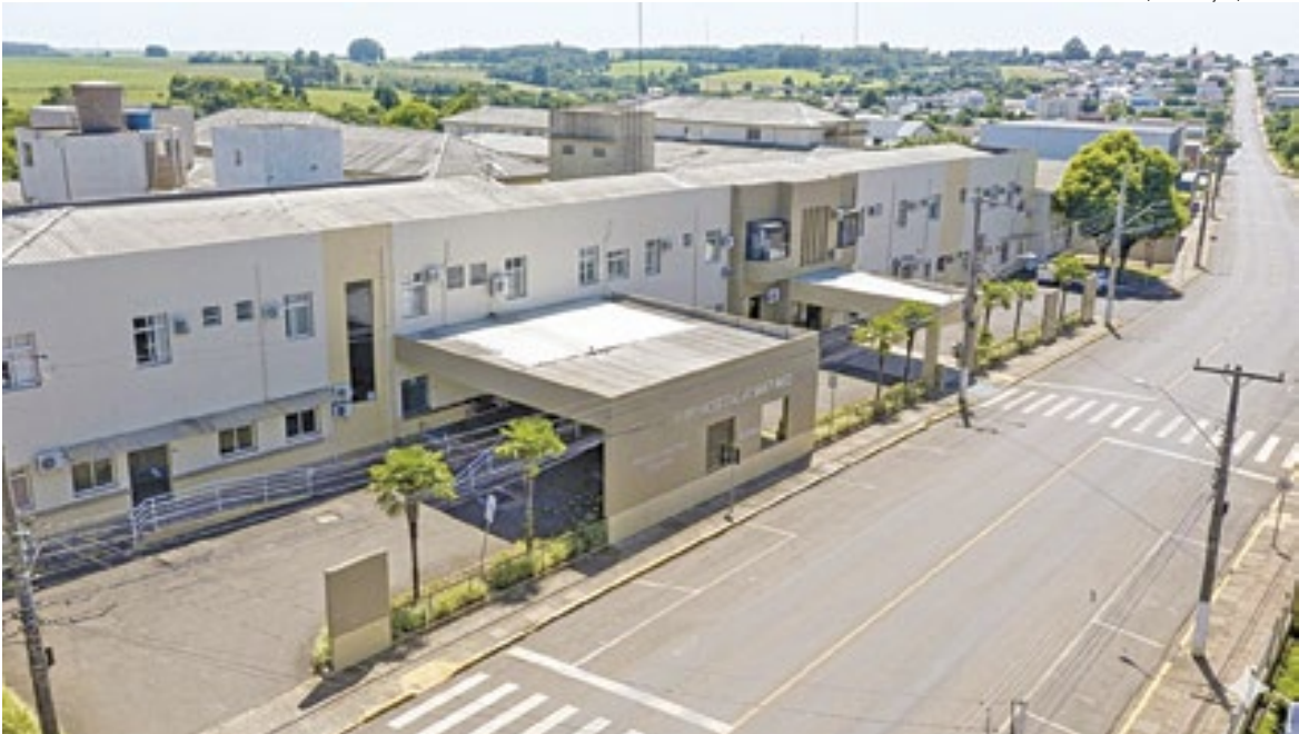
Cerca de 90% da estrutura física da casa de saúde sofreu algum dano por conta da chuva de granizo registrada no fim de semana
