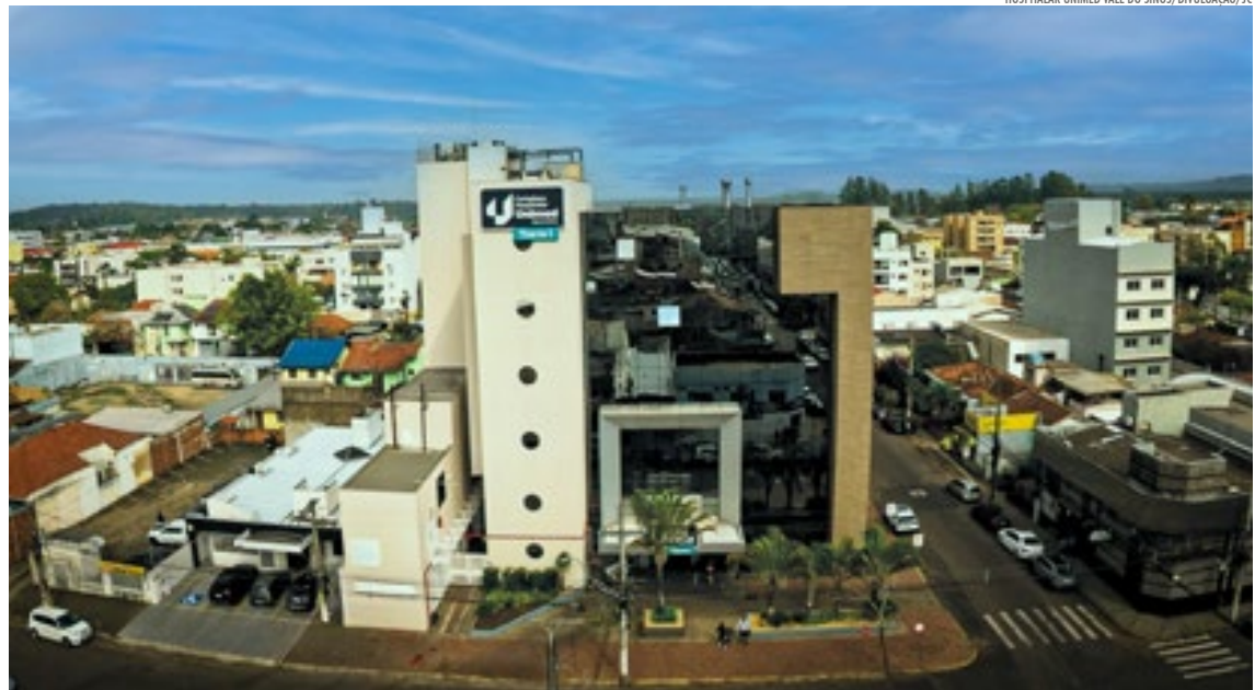
Estrutura conta com 2 Torres em NH e 1 Torre em SL e recebeu investimento de R$ 378 milhões
