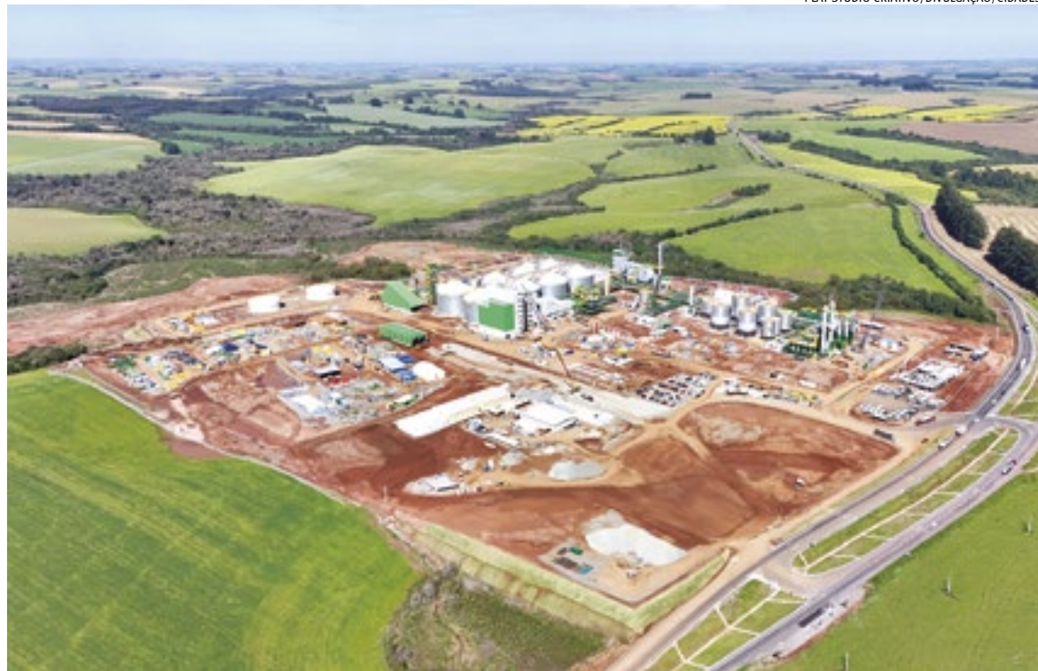
Unidade está em construção às margens da BR-285 e vai atuar na produção de glúten, etanol e na captura de gás carbônico
