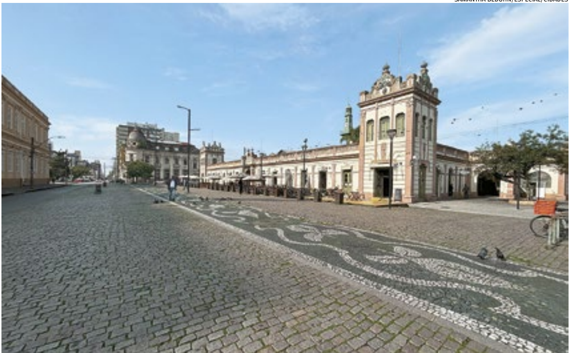
Obras previstas no edital, que deve ser lançado até o fim do ano, contemplará reforma da cobertura e pintura da fachada
