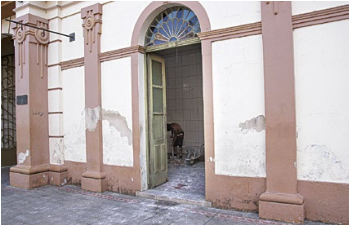
Banheiros do prédio estão em reforma desde abril, que acontece a partir de valores que vieram via medidas compensatórias
