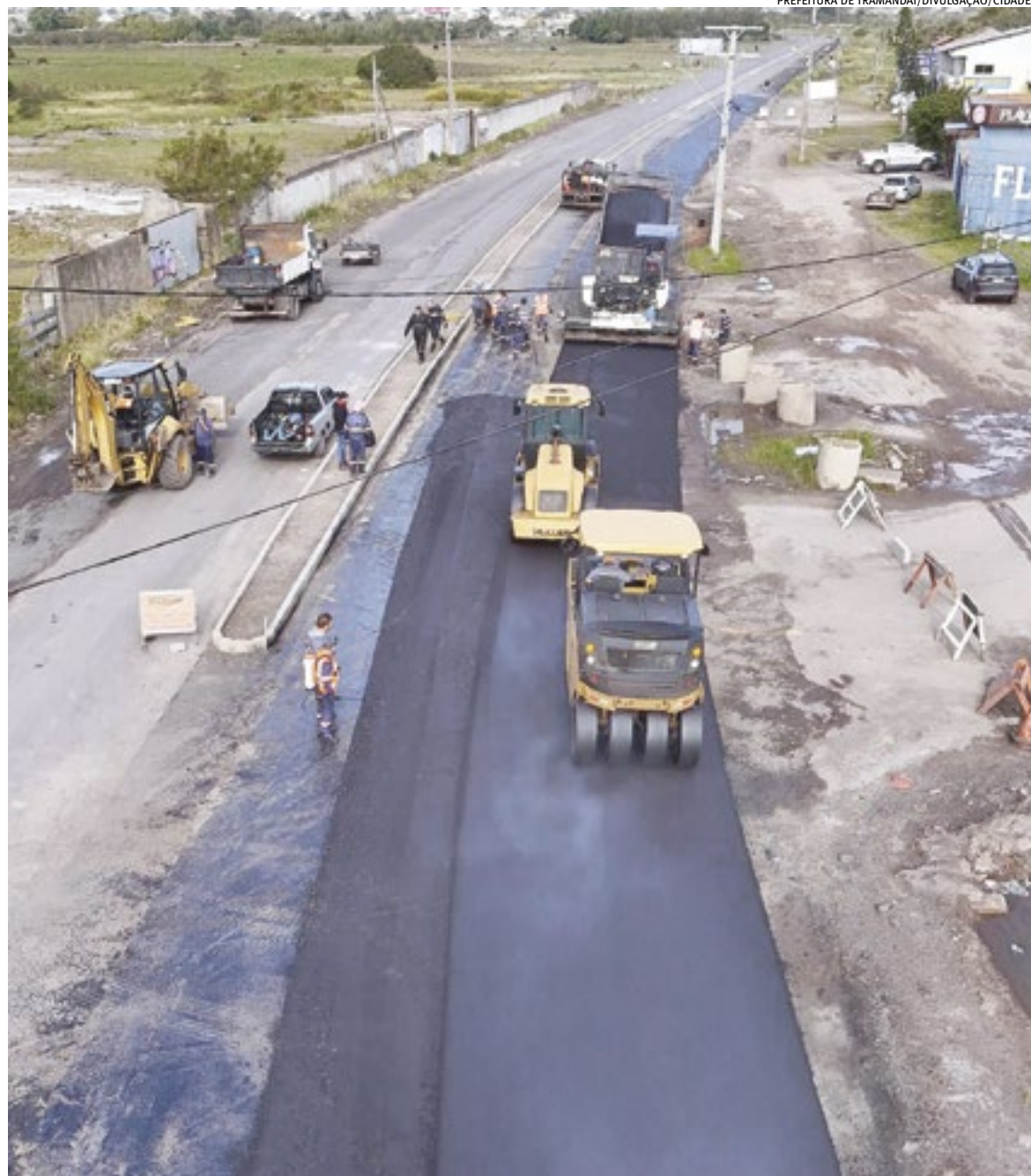
Prefeitura tem programa de R$ 200 milhões em obras urbanas, a fim de criar infraestrutura voltado ao crescimento da cidade
