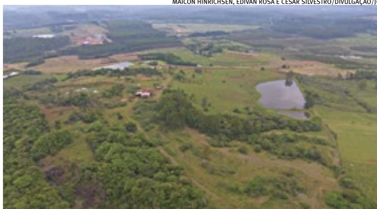
Imagem aérea do local onde ficará o aterro industrial em Montenegro
