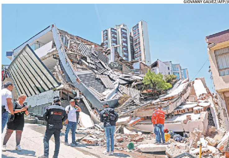
Equipes de resgate e civis buscam pessoas entre os escombros de prédios
