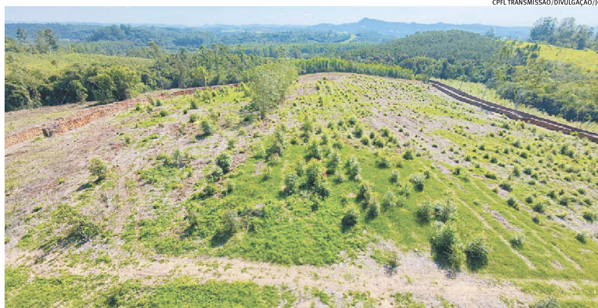
Terreno em São Sebastião do Caí já começou a ser preparado para instalação do canteiro de obras
