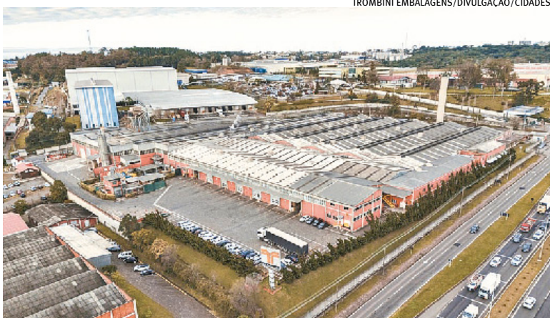
Trombini projeta incremento de 15% a 20% no faturamento quando obra for concluída
