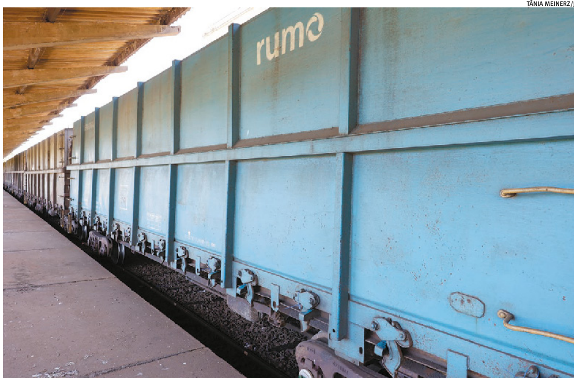
Enchentes de 2024 danificaram a ligação ferroviária e obrigou empresas a utilizarem as rodovias para o escoamento da produção
