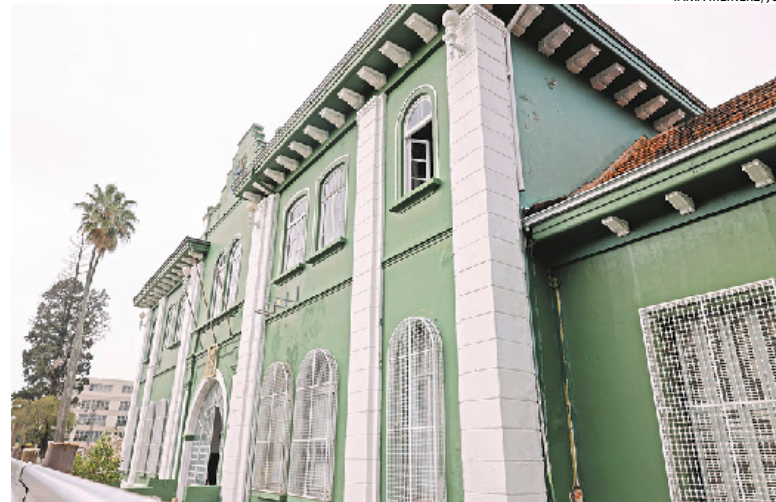
Edificação da década de 1920 não é tombada pelo patrimônio histórico
