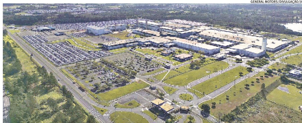
Modelo de condomínio industrial concentra 14 sistemistas junto à planta da General Motors em Gravataí
