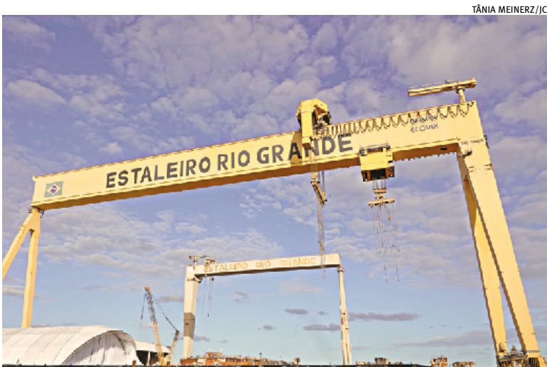
Estrutura será enviada ao estaleiro gaúcho para destinação sustentável
