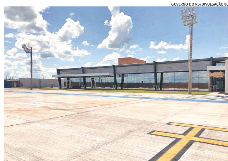
Expectativa é de que as obras no terminal sejam concluídas em 2028
