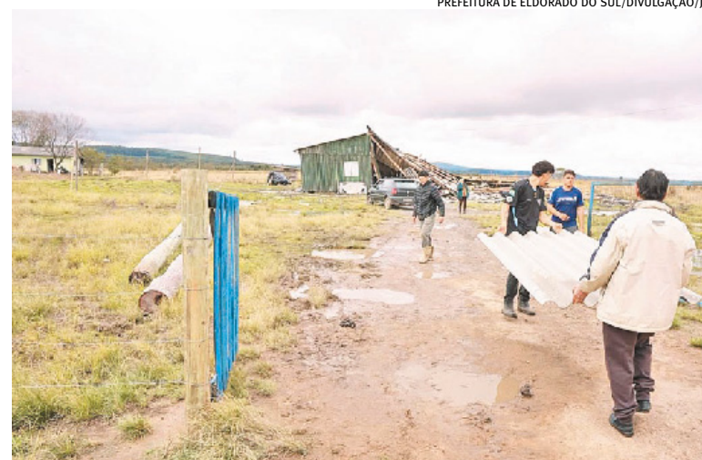
Defesa Civil distribuiu telhas aos atingidos por tempestade
