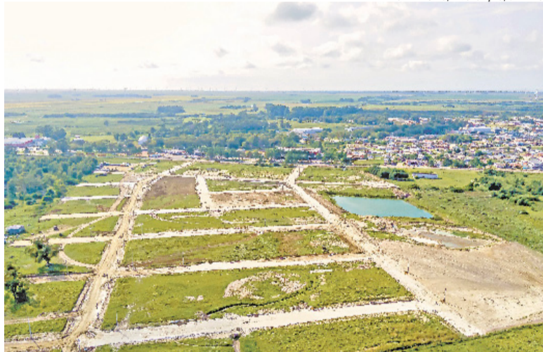
Construtora finalizou obras de infraestrutura no local, que tem 90% da área já vendida
