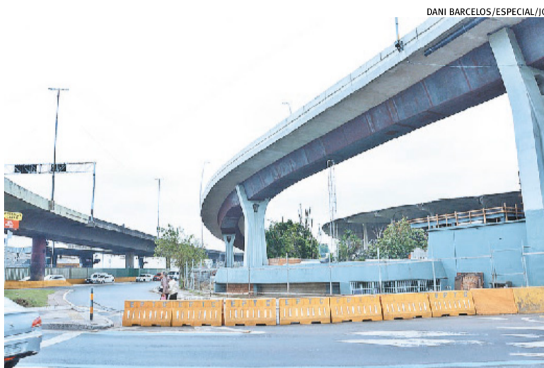
Passagem de acesso à avenida Castelo Branco é liberada pontualmente
