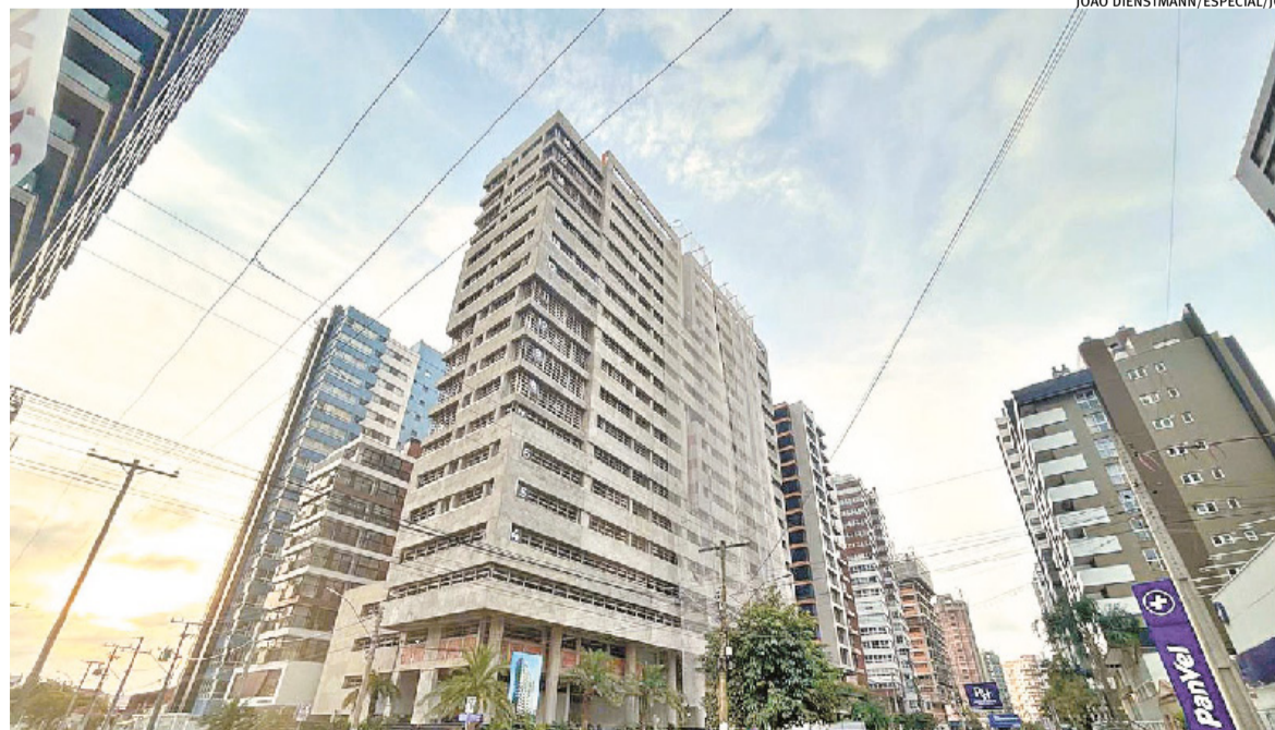
Litoral Norte tem o 2º metro quadrado vertical mais caro do Estado; na foto, prédio em construção em Torres
