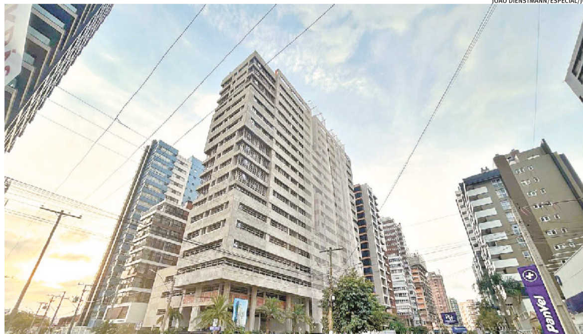
Litoral Norte tem o 2º metro quadrado vertical mais caro do Estado; na foto, prédio em construção em Torres
