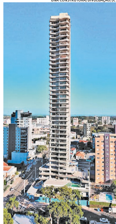
Estrutura com 140 metros de altura foi entregue em fevereiro
