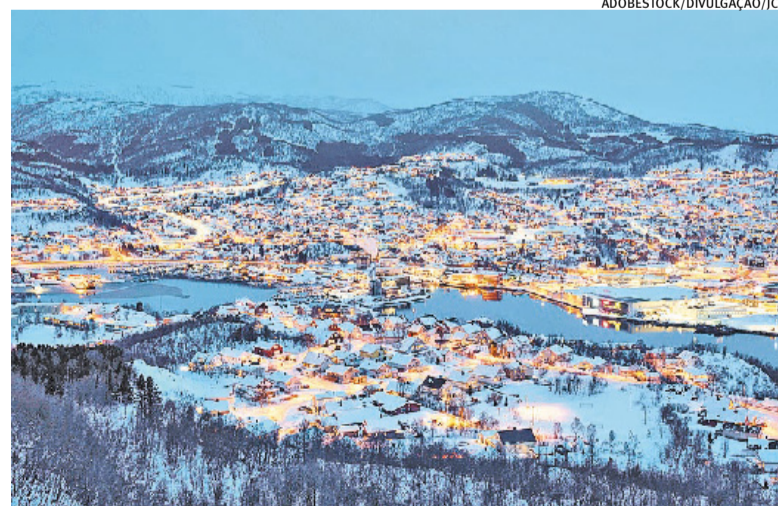
Estrutura está sendo construída no norte da Noruega
