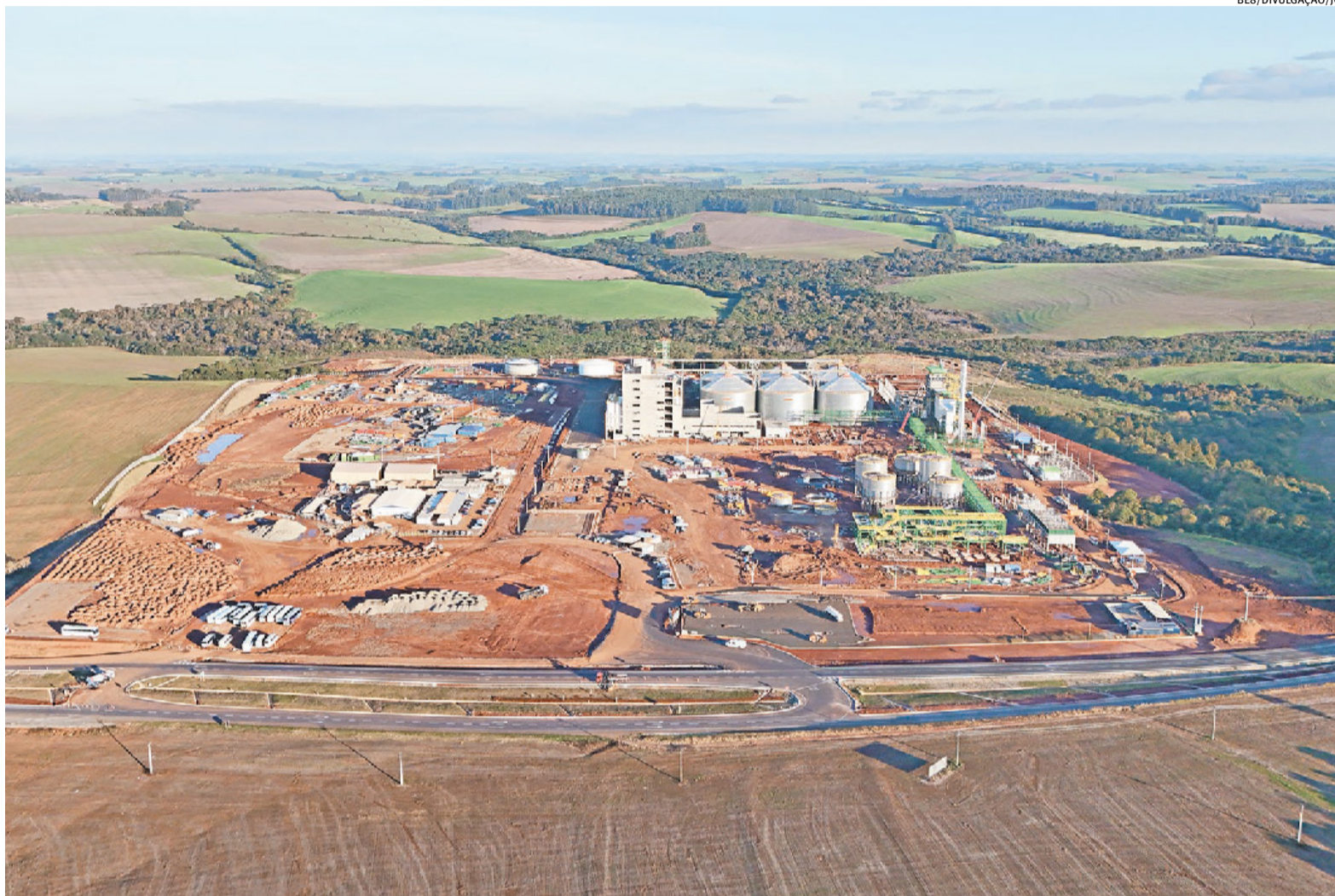
Cerca de 75% das obras já foram realizadas; usina em Passo Fundo fabricará etanol, hidrogênio verde, glúten vital, DDGS e CO 2 purificado
