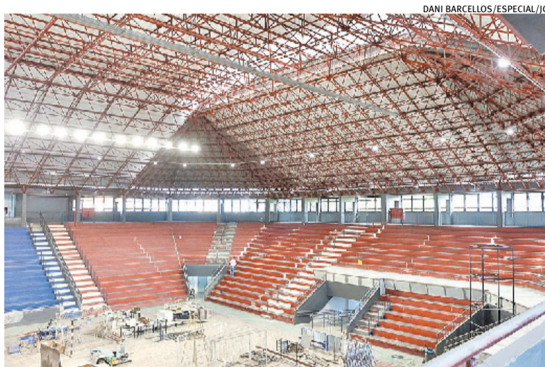
Revitalização do espaço já conta com 75% das obras concluídas
