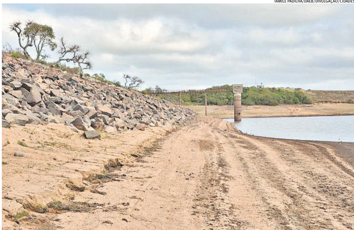
Barragem da Sanga Rasa, principal fonte de abastecimento em Bagé, chegou a mais de nove metros negativos, segundo o Daeb
