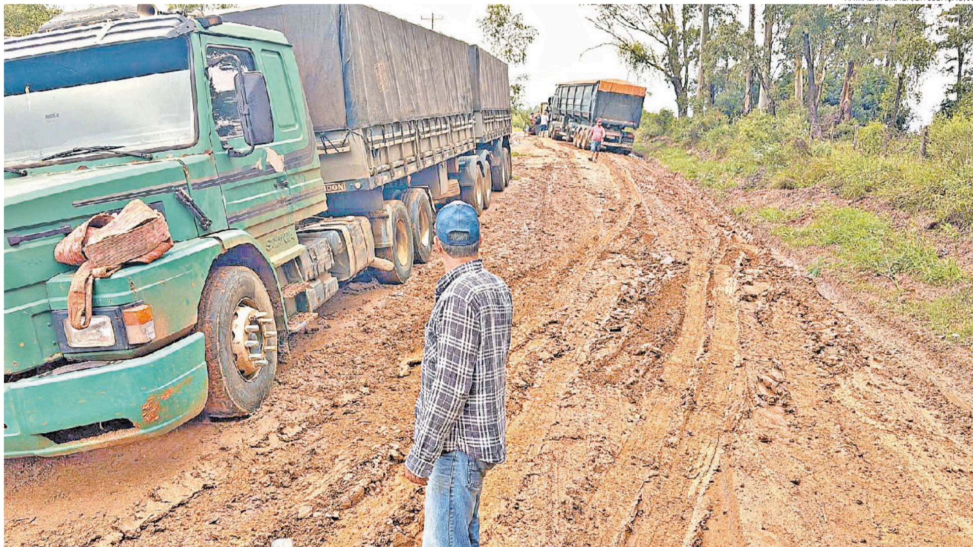
ERS-630, entre Dom Pedrito e São Gabriel, está sem pavimentação e enfrenta problemas de trafegabilidade, o que impacta o escoamento da produção na Campanha Gaúcha
