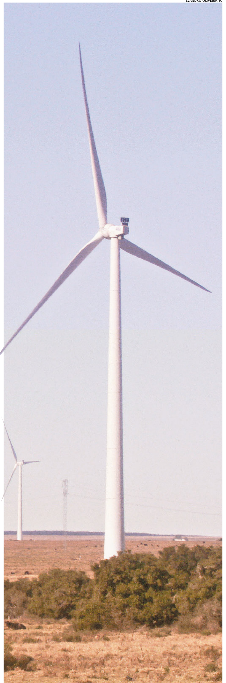
Parque eólico Coxilha Negra, da Axia Energia, em Santana do Livramento
