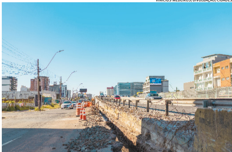
Mudanças ocorrem em função da montagem de vigas da obra no viaduto da rodovia
