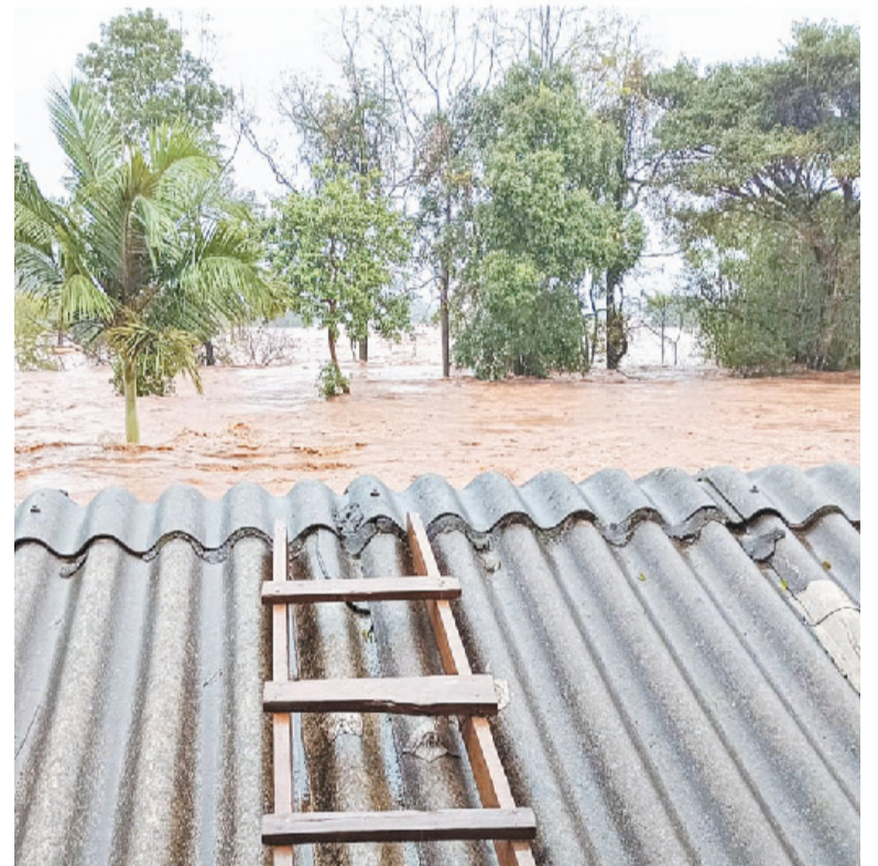
Abel Dullius teve que se abrigar no telhado de casa para aguardar resgate em 2024
