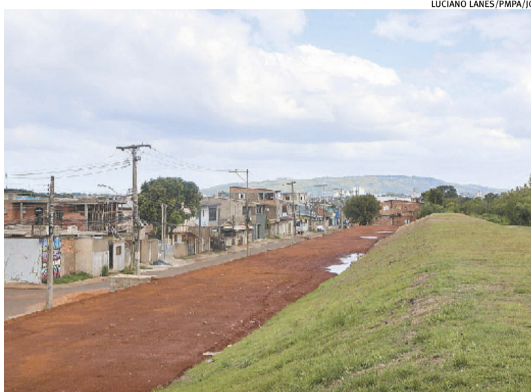
Entre as obras já concluídas está o dique no bairro Sarandi
