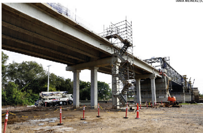
Investimento na estrutura sobre o Rio Jacuí foi atualizado para R$ 78,3 milhões
